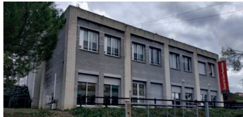
■ El Casal Cívic de Can Parellada s'ha quedat petit i queda pendent un projecte executiu per ampliar-lo i reconvertir-lo en centre cívic.
