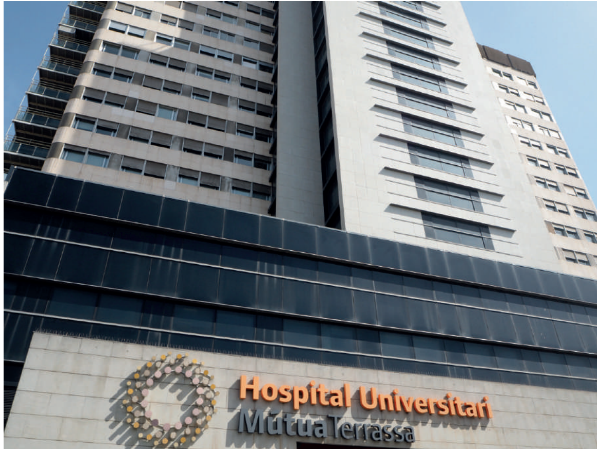
■ Edifici Universitari Mútua Terrassa
